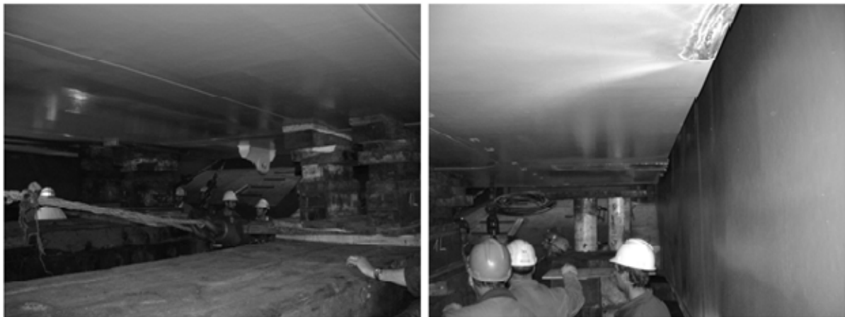
Slika 15. Hvatište A – Završno povlačenja kopača na konačnu poziciju Fig. 15 Connection A – final cutter ladder pulling to its final position
