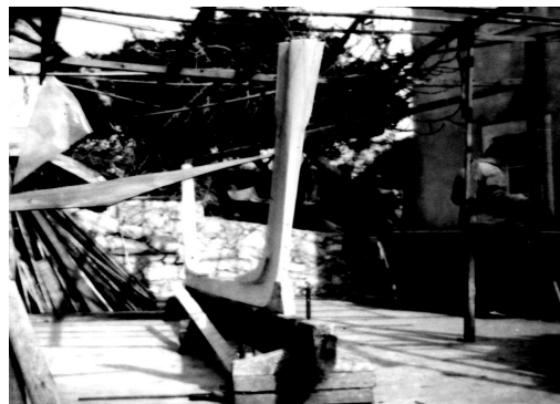
Slika 7 Prva faza gradnje („kantir“, „kolumba“ i „ašte“ –sve učvršćeno u okomicu „pjumbin“)
