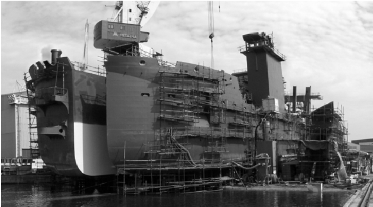
Slika 8. Brod u gradnji na navozu – Gr. 481
