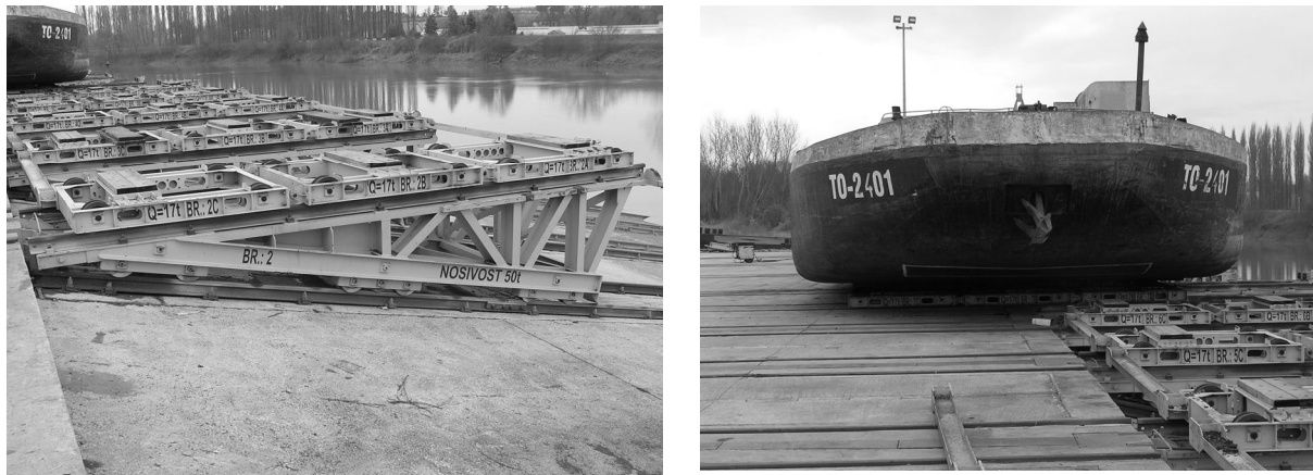
Slika 8. Slipni uređaj za transport i predaju broda vodi
