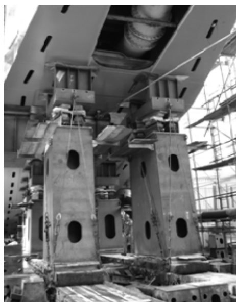
Slika 11. Detalj oslanjanja kopača na saonice
