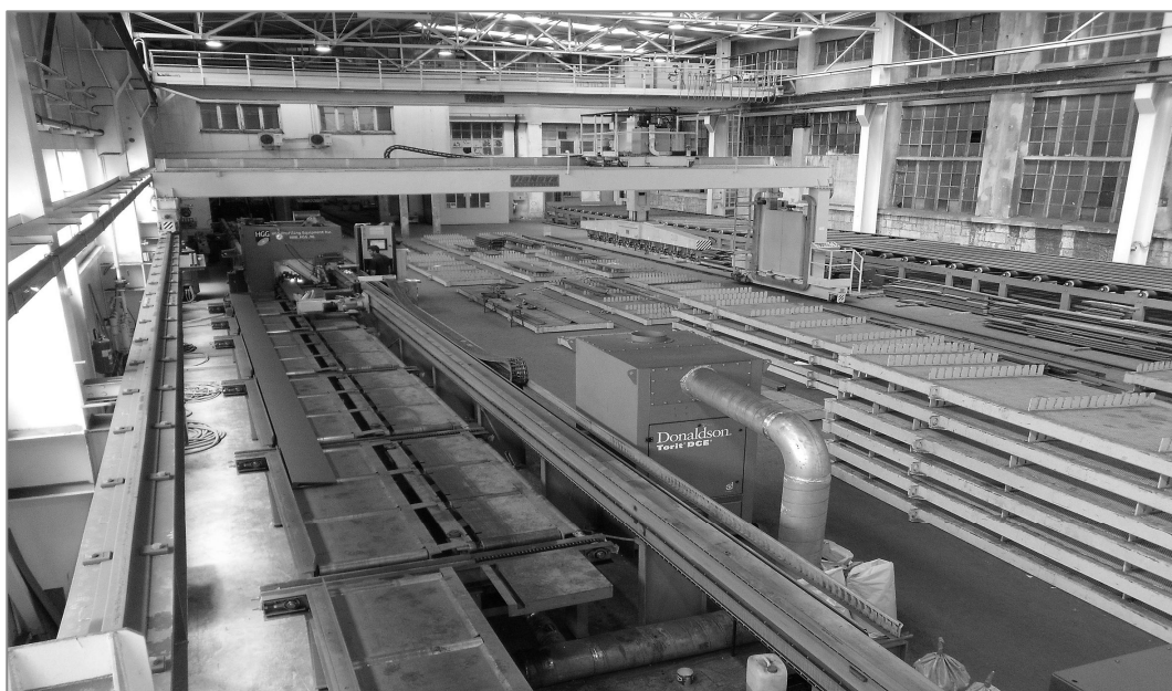
Slika 2. Fotografija projektirane i instalirane robotizirane linije za obradu profila, [18]
