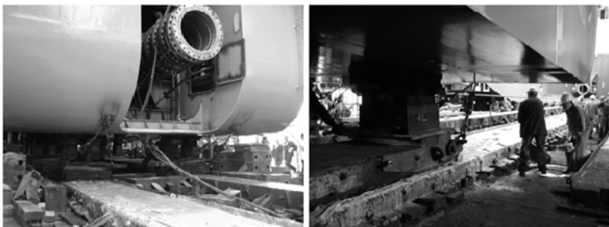
Slika 13. Hvatište A – početak povlačenja kopača
