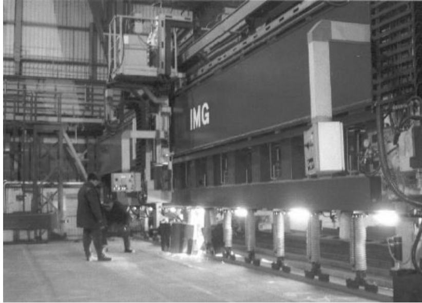
Slika 9. Portal za zavarivanje profila
